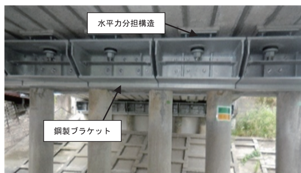
写真5.1 補強後状況
