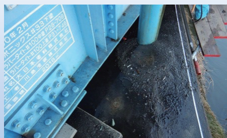
図-8 排水流末位置(A2下り線G1桁)
