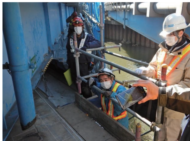
図-10 AR技術による設計構造投影時の様子
