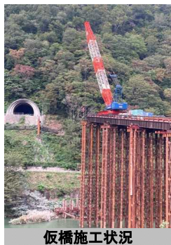
仮橋施工状況
