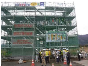
下部工事見学状況
