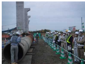
基礎工事見学状況
