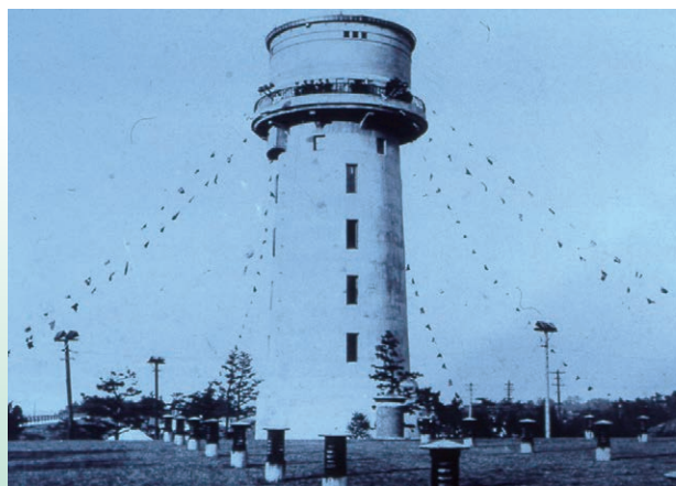
写真8 東山配水塔(第3期拡張事業)
