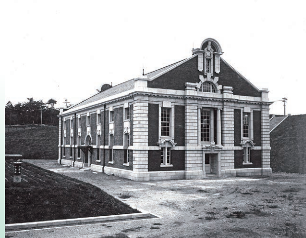
写真4 創設時の鍋屋上野浄水場旧第1ポンプ所
