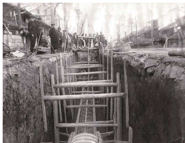
写真3 創設期の下水道工事
