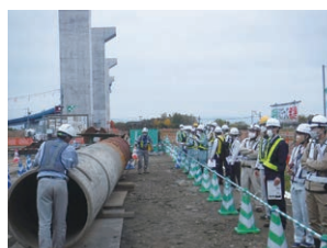
基礎工事見学状況
