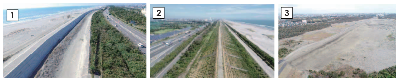
図1 浜松市沿岸域防潮堤
