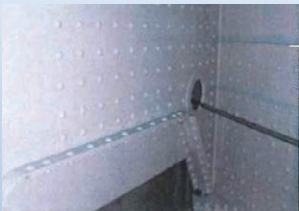
写真-6 本施工完了
