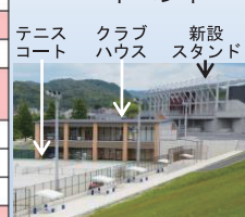
図-10 クラブハウスの外観
