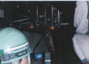
写真-5 本施工状況
