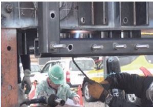
写真-4 試験施工状況
