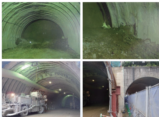
写真-2 施工状況の見学
