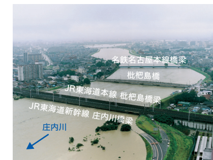
写真1 JR東海道新幹線橋梁
