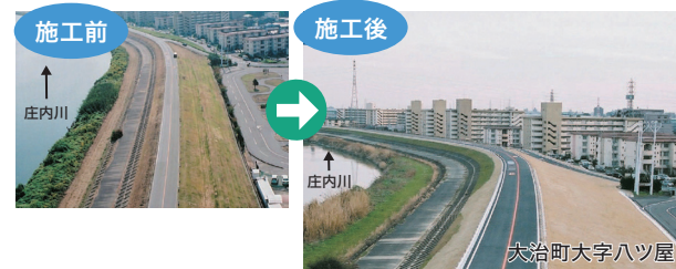
写真4 築堤・堤防補強 13.6km
