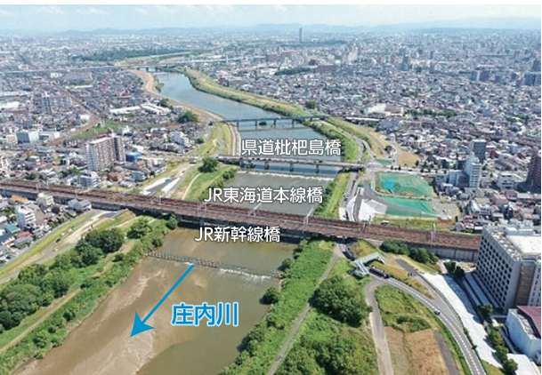
写真12 橋梁改築(JR新幹線橋等3橋)
