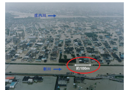
写真3 新川堤防決壊
