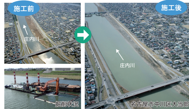
写真5 河道掘削 約140万m 3
