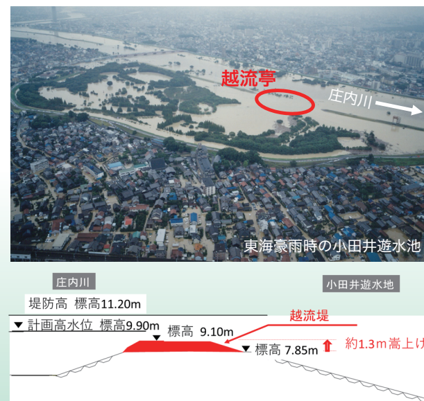
写真6 小田井遊水池の改築 越流堤約1.3m嵩上げ
