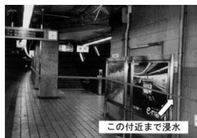
写真-1 東海豪雨時の地下鉄浸水 (平安通駅構内)
