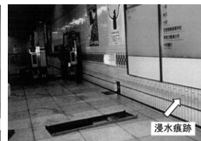
写真-2 東海豪雨時の地下鉄浸水 (野並駅コンコース)
