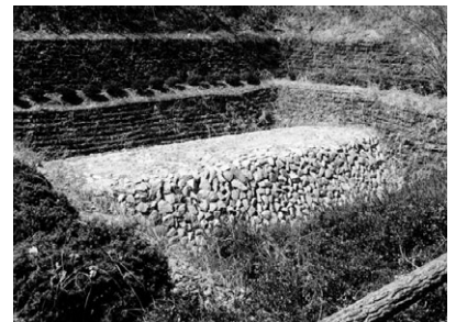
写真一2 大崖砂防ダム (長野県南木曾町蘭川支川) 撮影 H10.3.28
