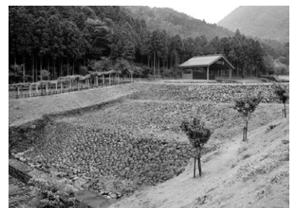
写真一4 羽根谷砂防ダム (岐阜県南濃町揖斐川支川) (平成10年文化財指定) 撮影 H11.7.13
