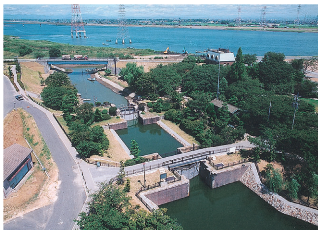
写真一4 船頭平閘門
