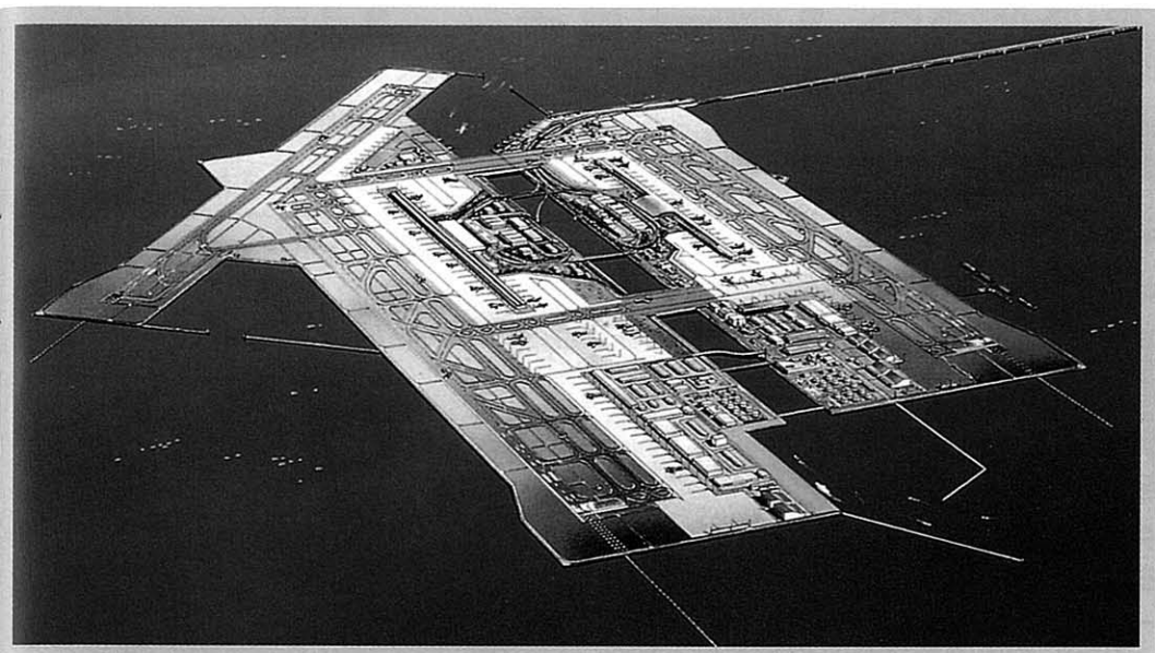
●1994年9月4日開港した関西国際空港
