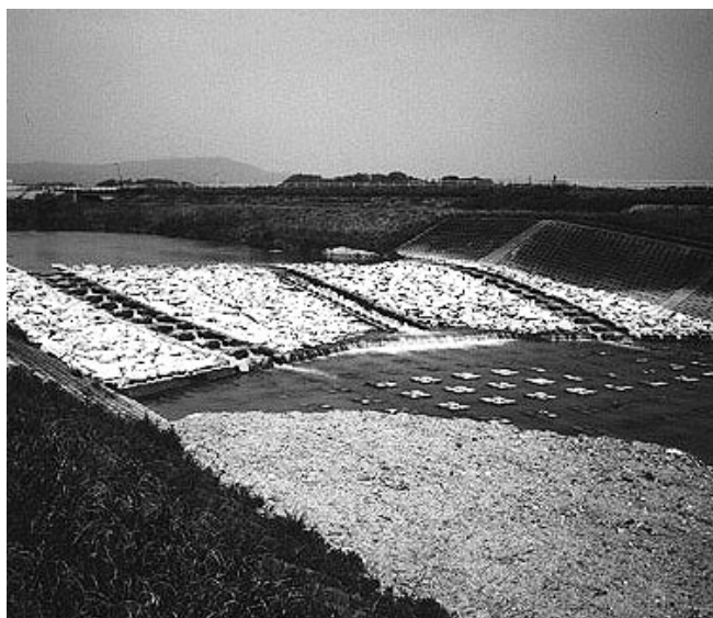
■図-6 竣工後の全景
