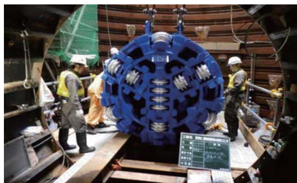
写真 11 シールド工法（併設水路工事）
