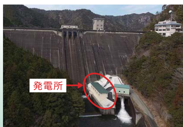
写真 14 宇連ダム発電所
