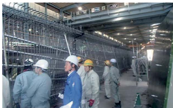
PCコンボ桁製作ライン 見学状況
