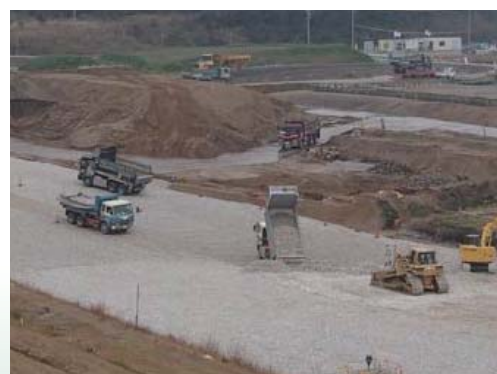
写真 12 上流側補強盛土
