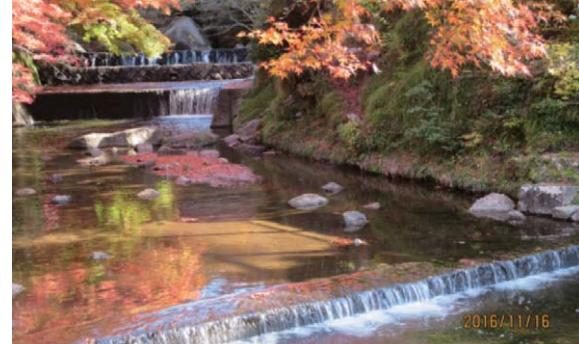
写真-19 鳥原川 高さを抑えた床固め群
