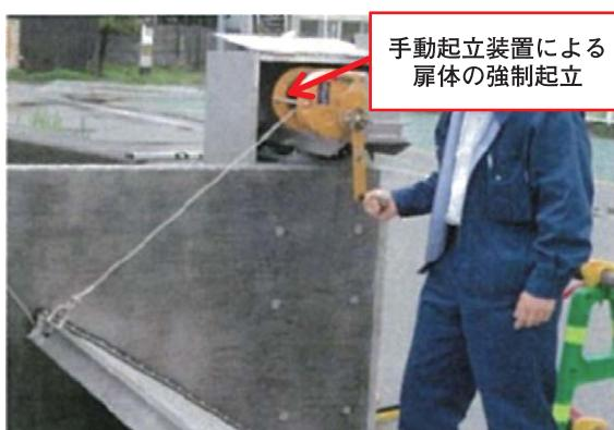
図-13 手動起立装置による扉体の強制起立<sup>3)</sup>
