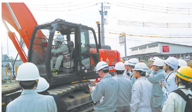
ICT 活用現場見学風景
