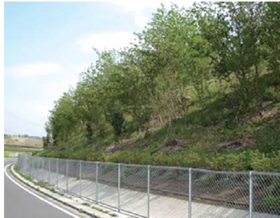
写真⑨ のり面への植栽状況
