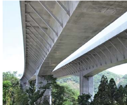
写真① ストラット付 PC 箱桁橋(郡界川橋)
