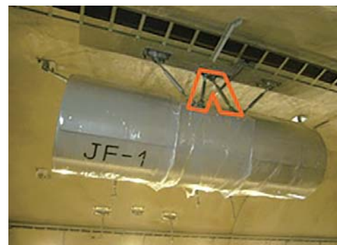
写真③ ジェットファンの追加支持金物
