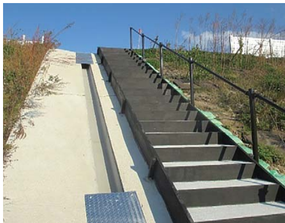
写真④ のり面点検階段と手すり
