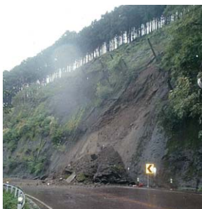
写真-3 土砂崩落に伴う小崩壊 (終点側より撮影)
