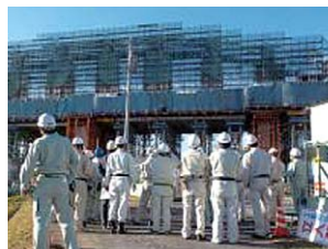
朝明川橋施工現場
