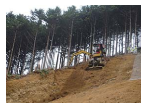
写真-9 クライミング式 バックホウ作業状況
