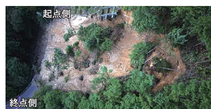
写真-7 UAV空撮による崩壊地全景写真
