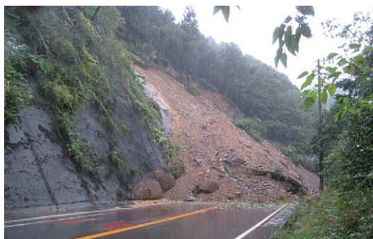
写真-1 対象斜面（起点側よりH26.10.23に撮影）
