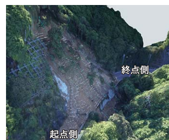
図-5 三次元レーザースキャナ等高線とUAV空撮画像合成
