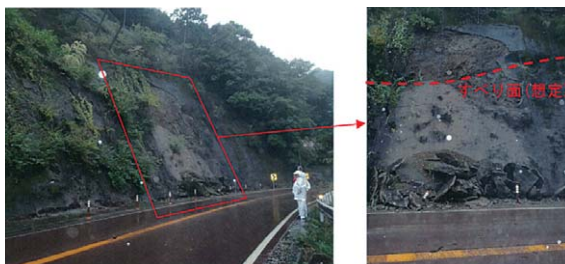
写真-2 モルタル剥落 (起点側より撮影)
