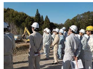
志知7号橋付近施工現場
