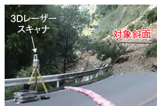
写真-4 三次元レーザースキャナ測定状況
