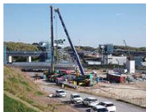
四日市JCT施工現場
