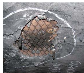
図-1 鶯谷トンネル西側坑口と内巻工剥落箇所
