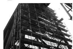
端支柱・枠組足場
