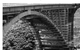
アーチリブ・補剛桁・吊足場
