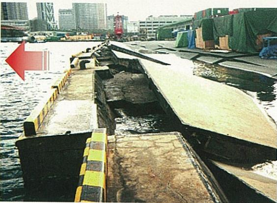
図-5 護岸の代表的被災事例(兵庫県南部地震)
