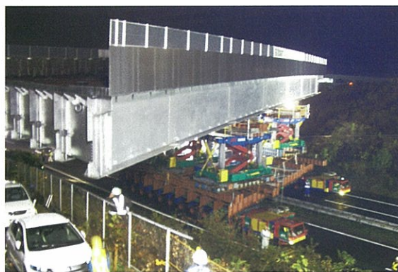
写真-5 多軸式特殊台車による運搬の様子
