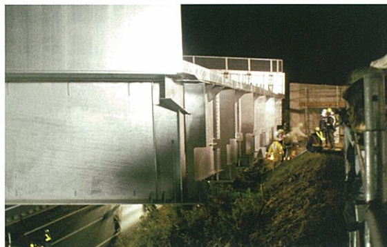
写真-6 桁降下・沓への据付の様子
