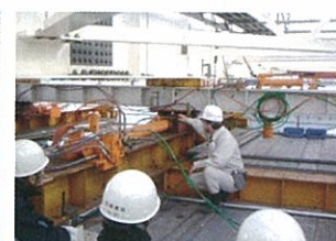
現場見学の様子(送り装置)
