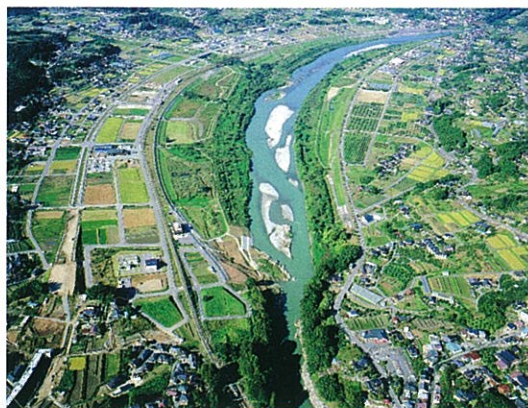
川路・龍江・竜丘地区の治水対策（引堤・堤内地盛土）
