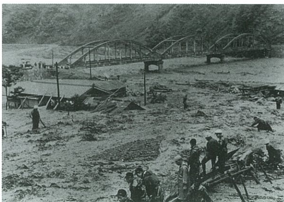
小渋川の被災状況(小渋橋下流)
