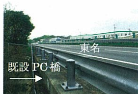
写真-3 既設PC橋
