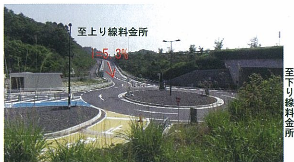
図-3 現況交差点(小型車対応)状況
