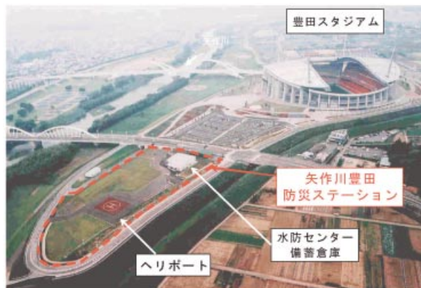
矢作川豊田防災拠点の写真
