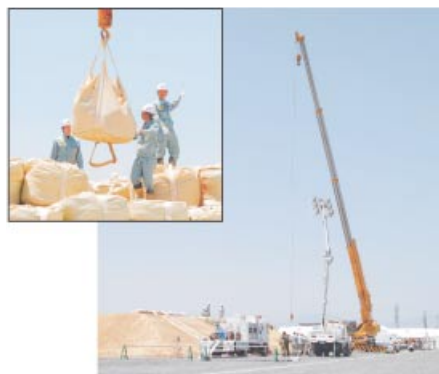
水害に備えた大型土のう積みによる緊急応急復旧訓練
