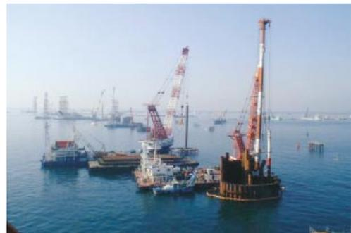
写真-4 鋼管杭の施工状況
