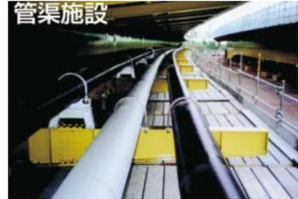
写真-2 橋梁部の配管状況
