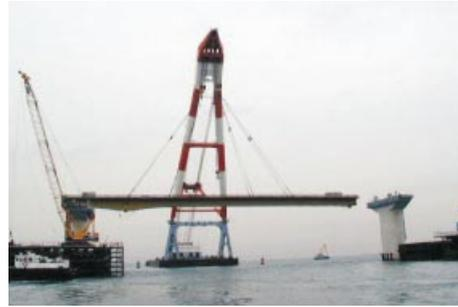
写真-2 主桁架設状況
