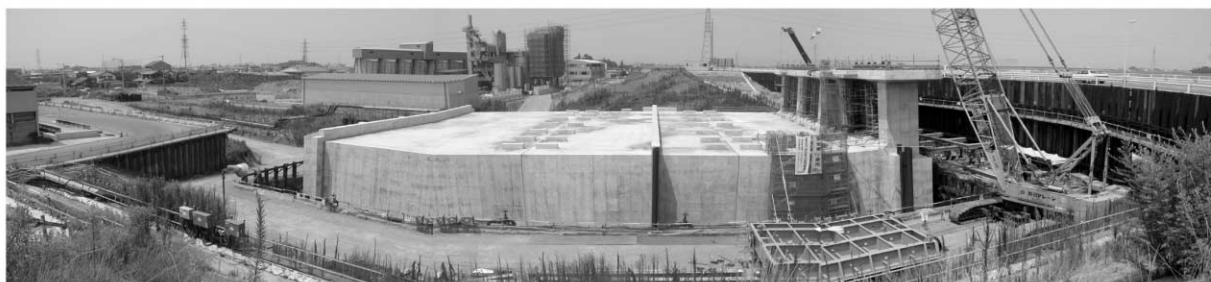
写真1 施工現場全景(H14.7撮影)
