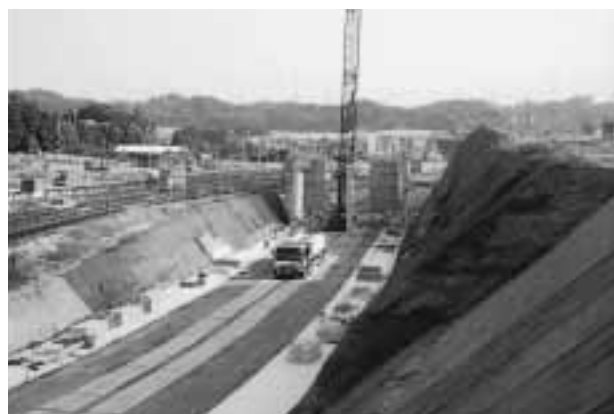
東名阪道と伊勢道直結工事現場
