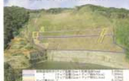
磨石山の緑化と植栽伐採木チップ 利用箇所
