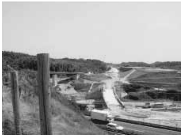
四日市JCT 工事現場
