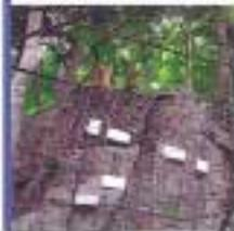
山間道路における落石・崩塌危険箇所は、箇所数が多く地形も急峻なため、常時監視は困難です。このため、光ファイバ自体をセンサとして用いた常時遠隔監視可能な計測システムを開発しました。
