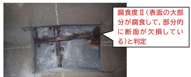
図-9 樋門頂版の腐食状況（腐食度Ⅱ）
