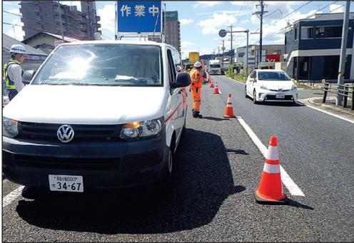
写真-3 FWD調査による交通規制状況
