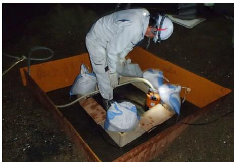
図-4 簡易土留めと止水状況
