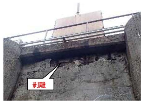
図-7 門柱1カーテンウォール剥離状況
