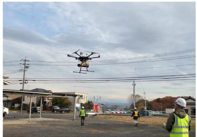
図-7 UAVレーザー測量の様子
