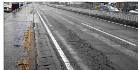
写真-2 縦方向ひびわれ区間
