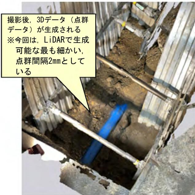
図-5 LiDARより生成した3Dデータ
