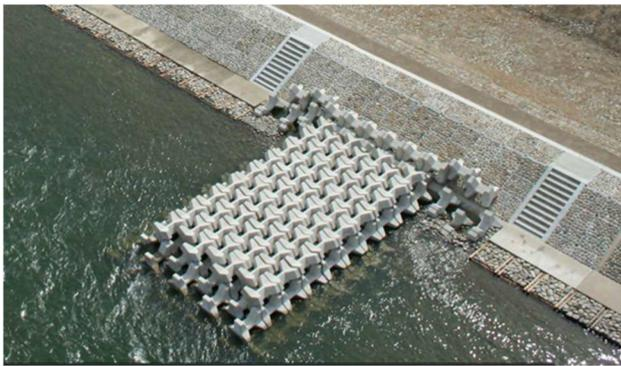
図-3 水制工完成写真 (H19年時)
