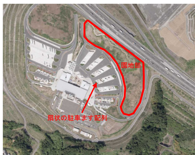
図-6 大型車駐車ます増設前 清水PA(上り) 2)
