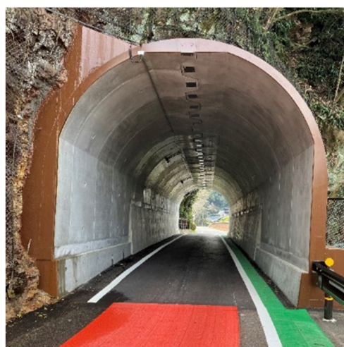
写真-7 対象トンネル状況(PCL工施工後)
