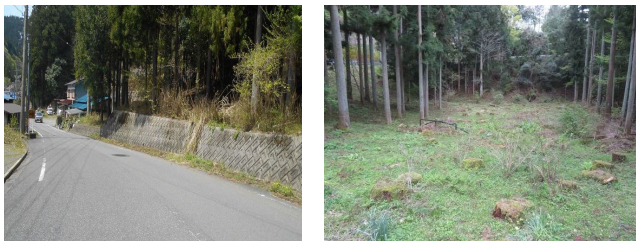
写真-1 現地状況 (左：現道 右：法尻部)
