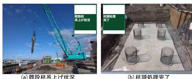
写真-1 A1橋台工事状況
