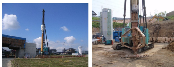
写真-2 施工機械（左：全景、右：攪拌機）
