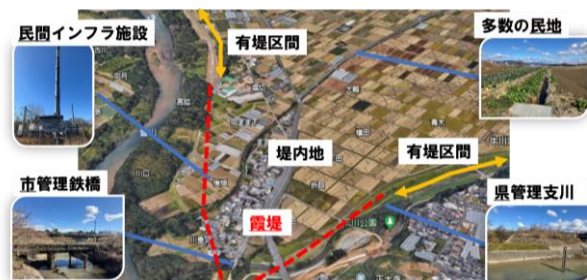
図-1 霞堤内地の現況（下条霞堤地区）
