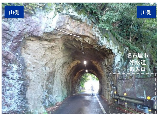
写真-1 トンネル現況(起点側)
