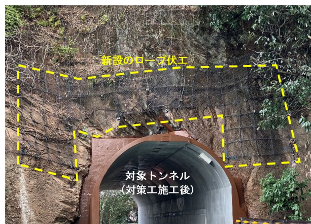
写真-6 ロープ伏工の施工後状況
