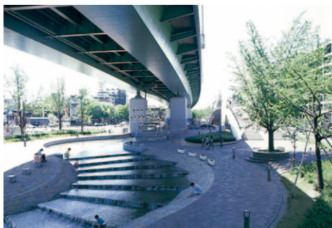
【名古屋高速高架橋】
