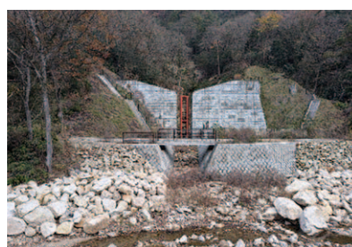
●美和ダムの土砂バイパストンネル出口
