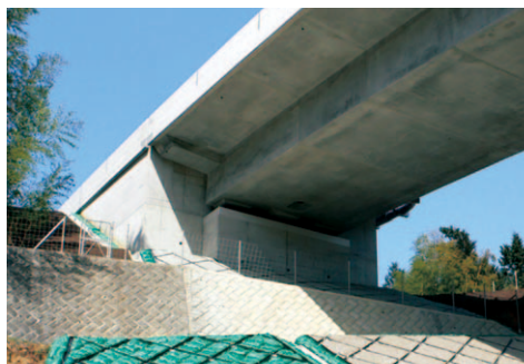
【飯橋道路橋梁】
