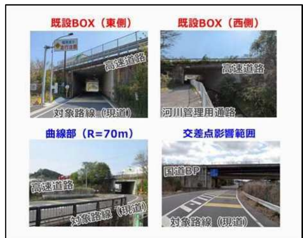
図-2 現地状況写真
