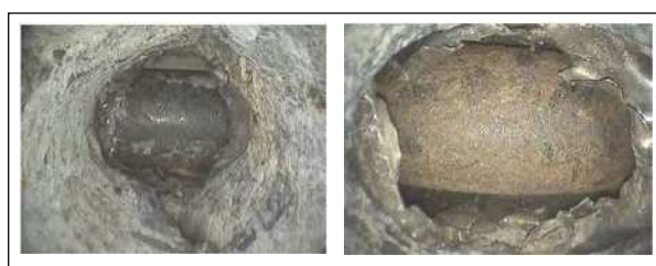
写真-1 削孔調査結果（代表箇所）
