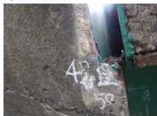
写真-2 A2橋台桁端部
