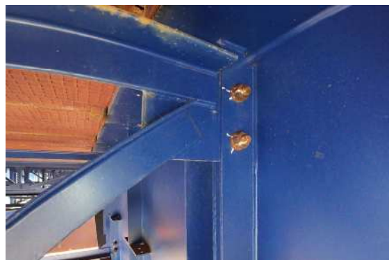
写真-2 UAVによるボルトの緩み確認状況
