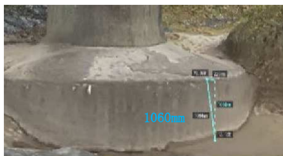
図-3 下部工天端部と河床間の計測状況
