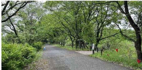
図-3 両地区の分断要素となっている旧堤防の様子
