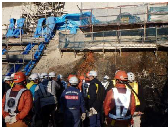
写真-4 左岸基礎掘削面における4者協議状況 （地質・設計・施工・発注者）
