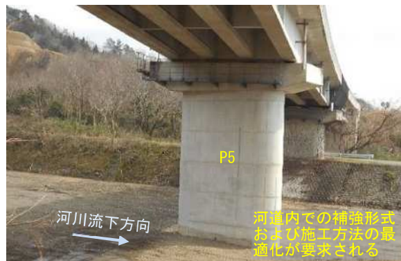
写真-3 河川内橋脚
