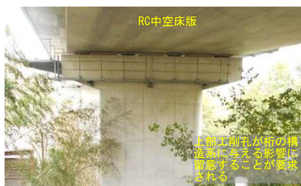
写真-5 上部工形式(RC中空床版部)
