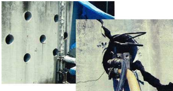
図-8 バースター工法施工状況図
