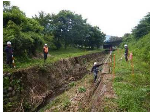
写真-4 複数人による現地確認
