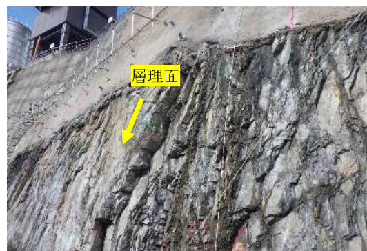
写真-3 法面に対して流れ盤構造となるチャート
