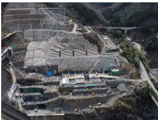
写真-1 新丸山ダム左岸掘削状況写真 令和7年3月 3)
