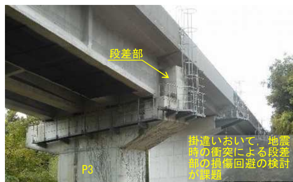
写真-6 掛違い橋脚 (P3)
