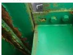
写真-1 主桁結合部
