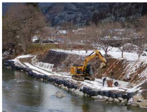
写真-5 災害復旧事業 施工状況
