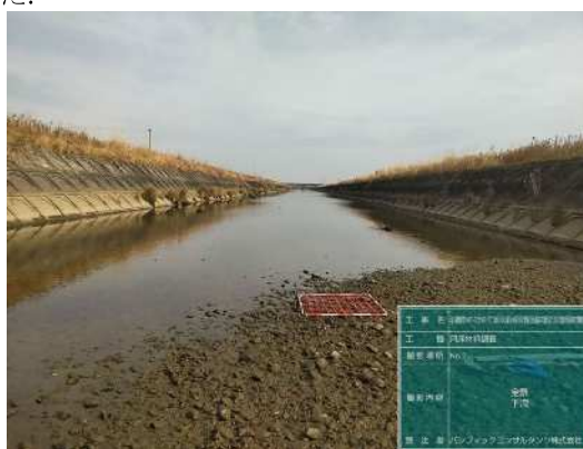
図-8 河道の現況【単断面／法面ブロック張り】
