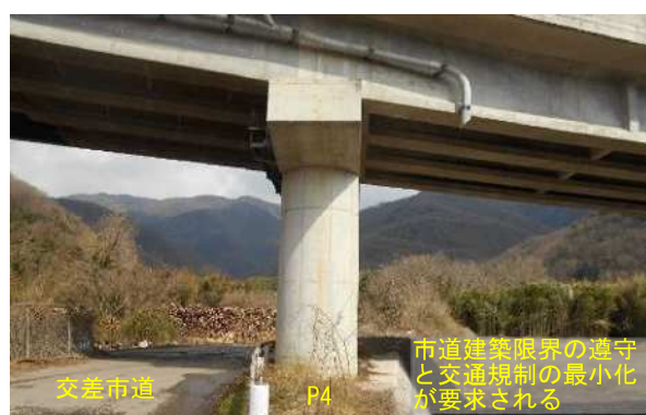
写真-4 堤体内橋脚
