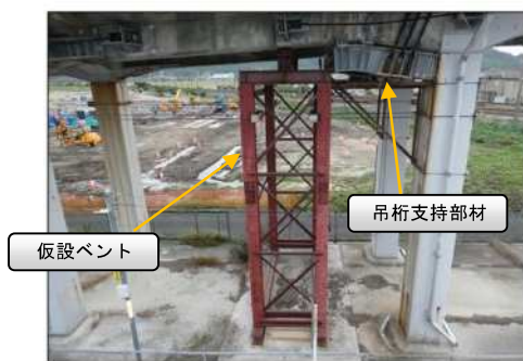
写真-2 仮設ベントと吊桁支持部材の状況
