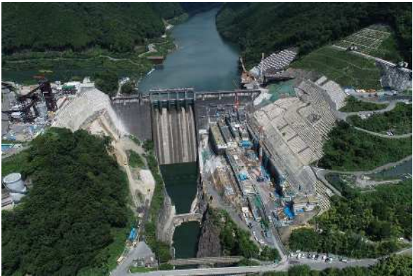
写真-5 新丸山ダム施工状況写真（令和8年8月） 3)
