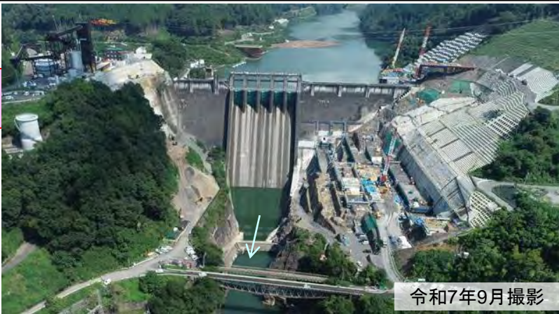
ダム本体工事（左岸基礎掘削・Co打設）の状況
