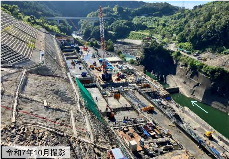
堤体より下流を望む（左岸基礎掘削・Co打設）の状況
