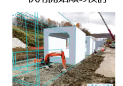
掘削作業時にARと比較
