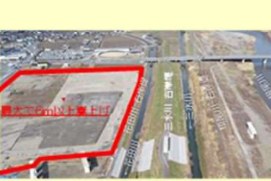
最大規模の高水による浸水を想定した拠点病院整備 (木曾川水系揖斐川、JA岐阜厚生連・大野町)
