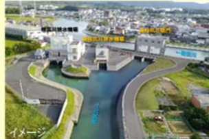
排水機場の増強 (宮川水系、中部地方整備局・伊勢市)
