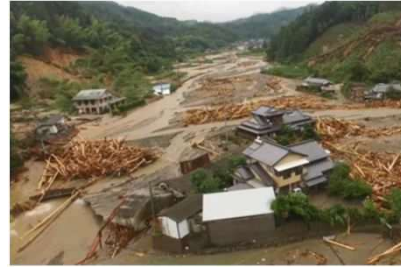
③ 赤谷川における浸水被害 (福岡県朝倉市)
