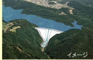
ダム建設 (豊川水系、中部地方整備局)
