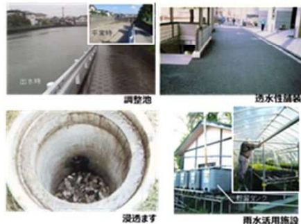
雨水貯留浸透施設の例
