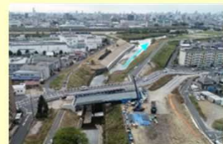
橋梁改築・堤防整備 (庄内川水系、愛知県)
