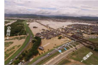
④ 小田川における浸水被害 (岡山県倉敷市)
