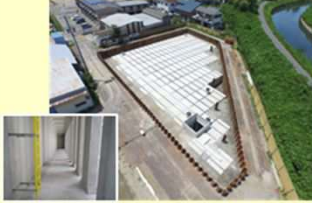
雨水(地下)貯留施設整備 (木曾川水系揖斐川、大垣市)
