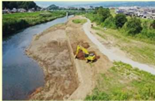
河道掘削 (狩野川水系、中部地方整備局)
