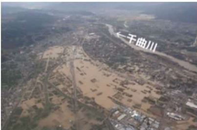
⑤ 千曲川における浸水被害 (長野県長野市)
