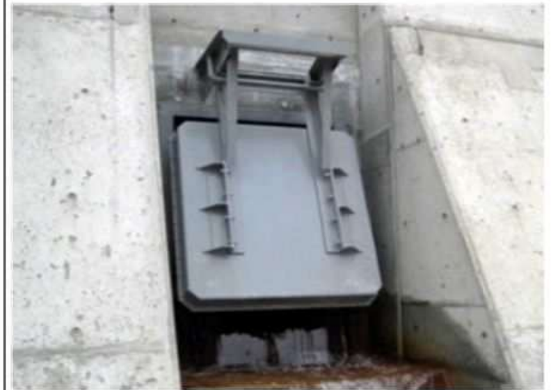
フラップゲート (操作員による扉の開閉が不要)
