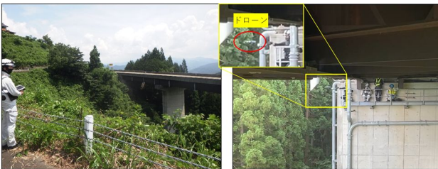
写真-6 ドローン撮影状況
