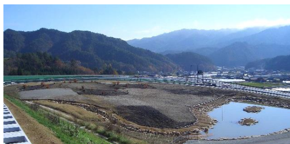
図-1 完成時（平成16年11月）の状況
