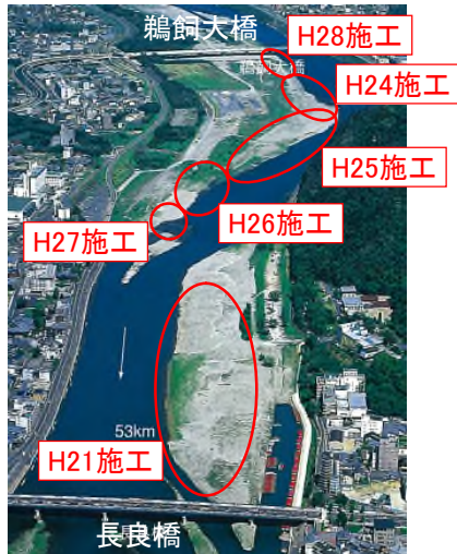
図-3 長良川中流部の礫河原再生工事の実施状況 5)
