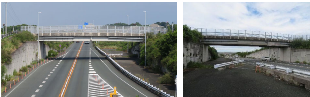
写真1 名古屋側から橋梁を望む 写真2 浜松側から望む
