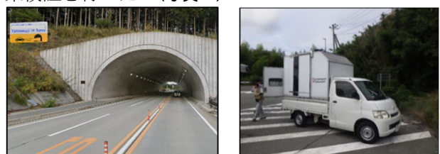
写真-2 対象施設及び作業状況
