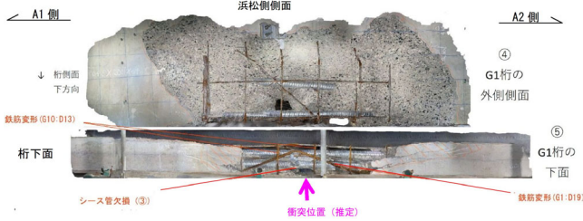
図-4 G1桁(桁側面・下面)
