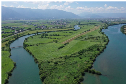
写真-1 岐阜県西濃地区、一級河川木曾川水系揖斐川、河床勾配1/4300、セグメント2-2（令和3年7月撮影）
