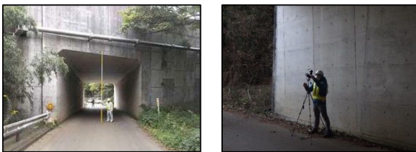
写真-1 対象施設及び作業状況
