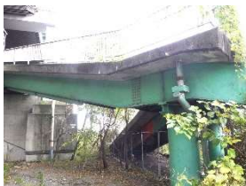
写真-1 橋梁全景
