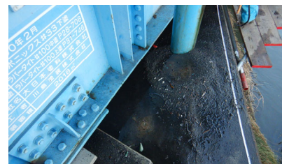
図-8 排水流末位置 (A2下り線G1桁)
