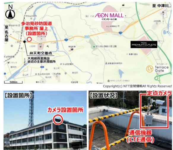
図-6 ライブ配信カメラの設置位置
