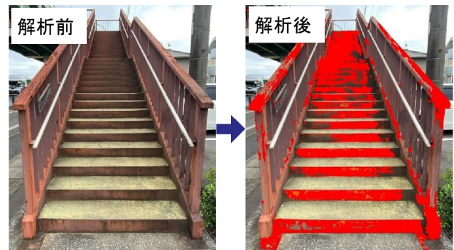
図-9 AIによる画像解析の結果(階段部-未塗装)
