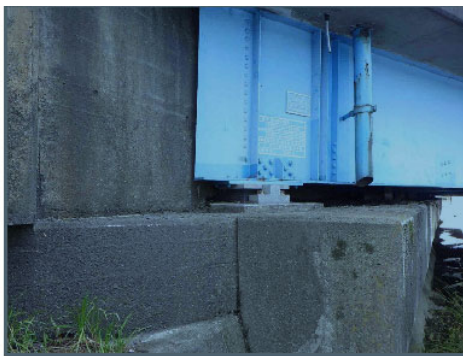
図-3 R2定期点検写真 (A2下り線G1桁)
