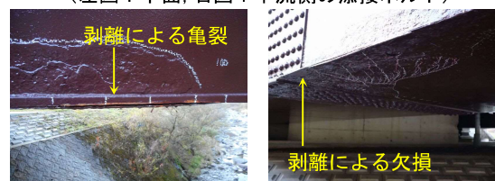
図-4 下フランジの腐食
