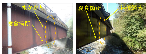
図-5 排水施設の状況 （左図：過年度点検時、右図：今回調査時）
