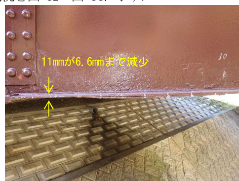
図-12 下フランジの腐食（側面）
