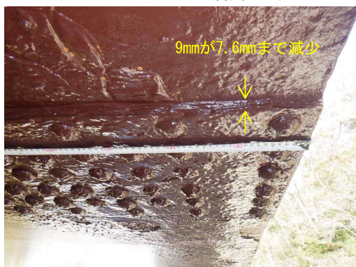
図-14 添接部の腐食
