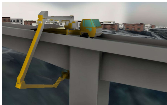
図-9 PC箱桁橋の柱頭部の下床版下面の点検
