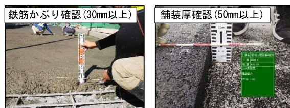
写真-6 施工管理厚確認状況
