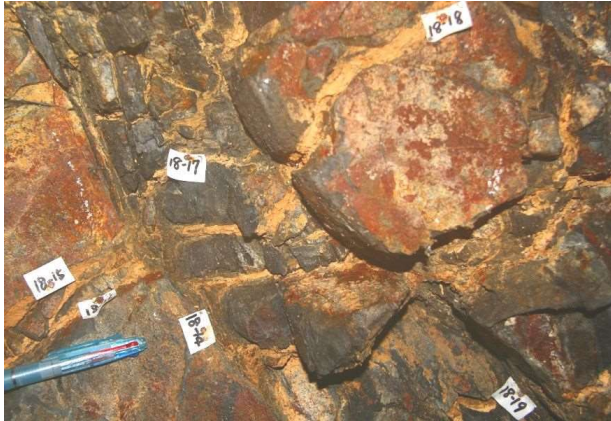
写真-1 横坑の緩み岩盤状況
