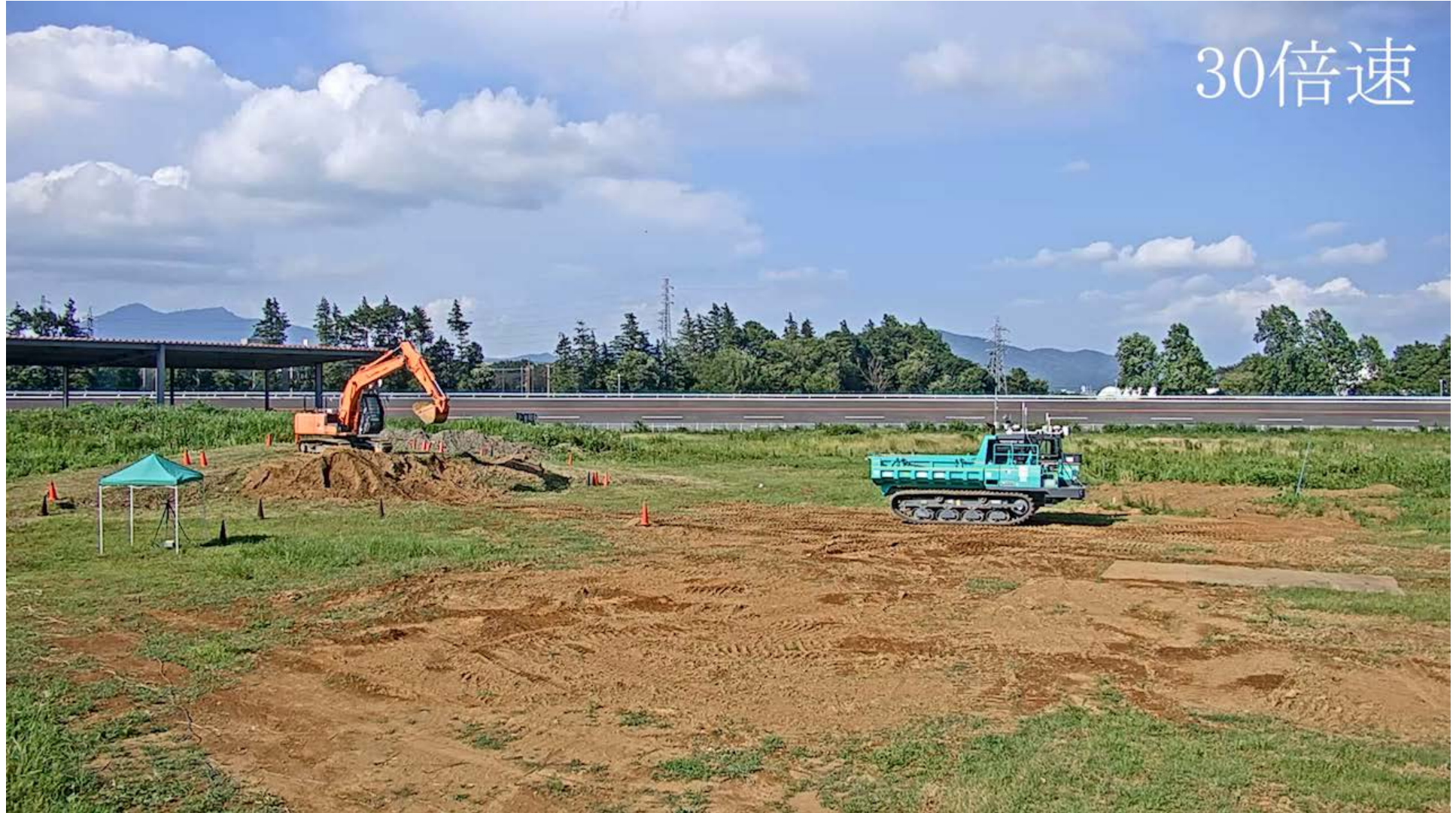
複数台建設機械の連携作業(掘削、積込、運搬)
