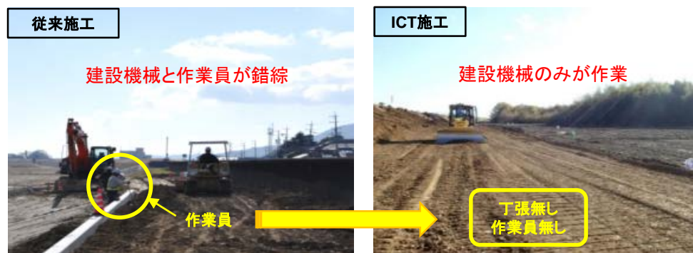
○ 従来施工とICT施工の比較
