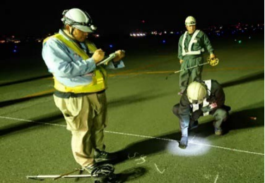
<ひび割れ計測>
