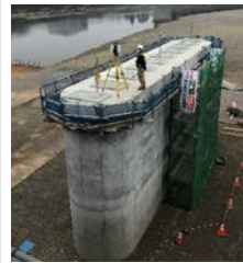
従来施工 (高所での測量)
