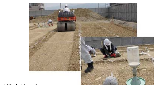
(従来施工) 砂置換による密度管理(部分的な管理)
