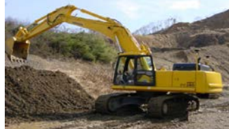
ICT建機による施工
