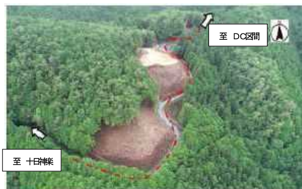
図-4 町道十日神楽線(区間3-B)の施工中の様子 1)
