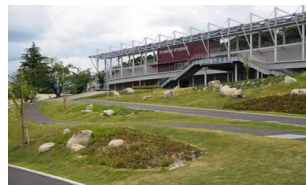
図-4 処分石材をベンチや景石として利用
