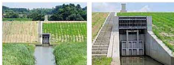
図-9 バランスウェイト式フラップゲート例※3
