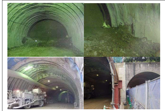
写真-2 施工状況の見学
