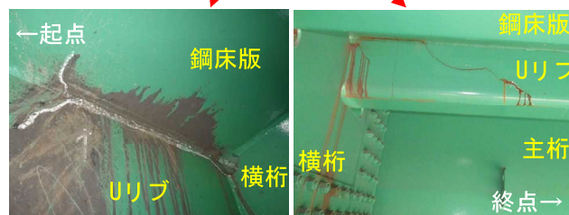
図-2 亀裂状況 (上図：全体状況、左図：起点側、右図：終点側)
