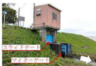
図-1 対象樋管写真
