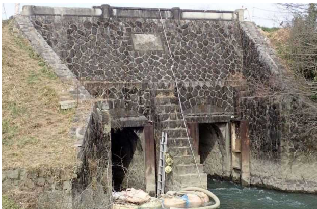
図-1 五六閘門（下流正面より）
