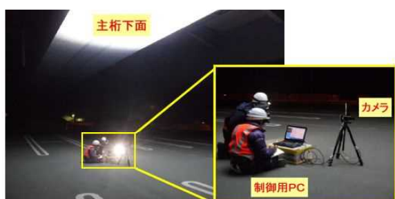
図-2 桁下面の動画撮影状況
