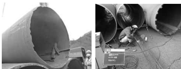
写真-4 ビットの摩耗（左：摩耗時、右：通常）
