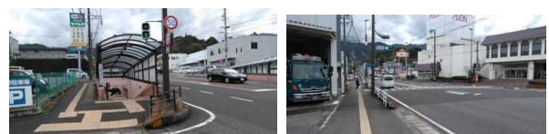
図-3 現道状況（歩道）
