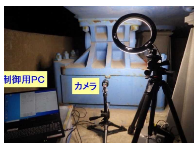
図-3 支承の動画撮影状況
