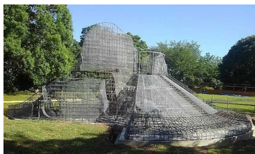
■鉄骨造形にラス網を成形した状態
