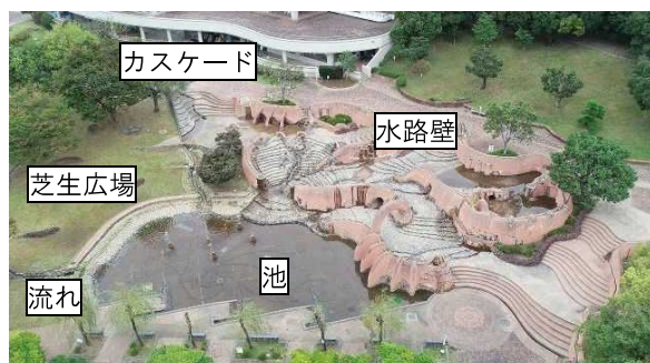
図-5 ドローン空撮写真
