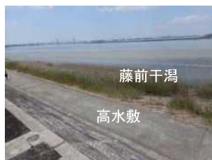
図-6 川表側の現地状況
