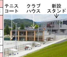
図-10 クラブハウスの外観
