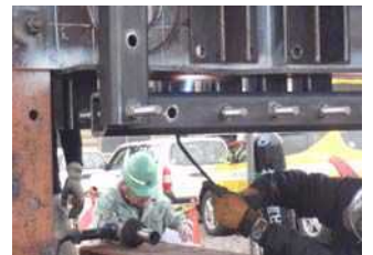
写真-4 試験施工状況
