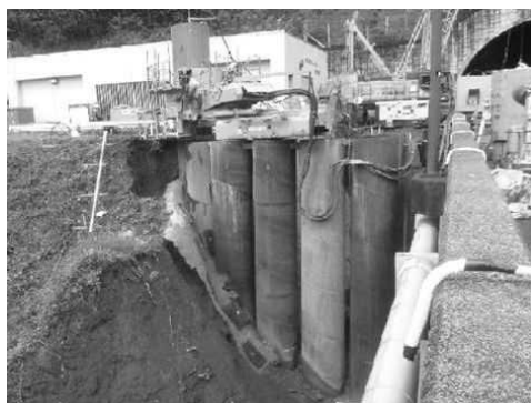
写真-3 ジャイロプレス工法施工状況
