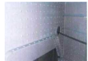
写真-6 本施工完了
