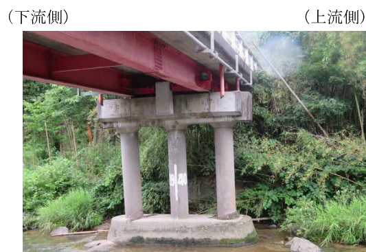
写真-1 P1橋脚
