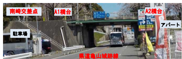
図-8 橋梁横過部を亀山 IC 方面から望む
