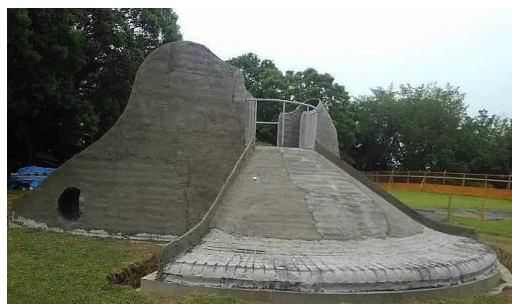
■モルタルを下塗りした状態
