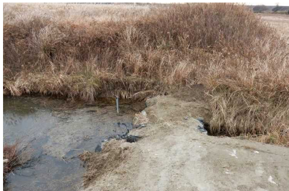
※第2回目汽水化施工時（撮影：2020年12月） 写真-1 土のうによるせき止め
