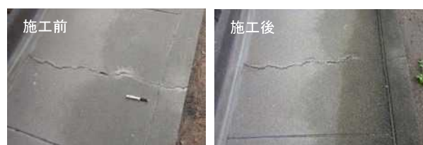
図-16 施工前後のべた基礎の状況
