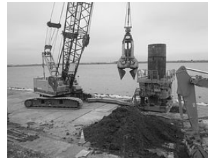
支障物撤去状況
