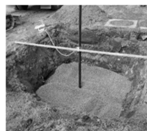
図-5 打ち込み井戸の掘削状況（左）と浸透ますの設置状況（右）
