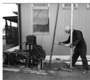
図-5 打ち込み井戸の掘削状況（左）と浸透ますの設置状況（右）
