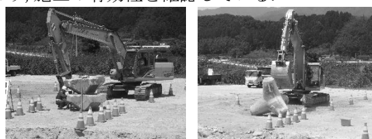
2tブロック連結の様子 5tブロック投入の資料
