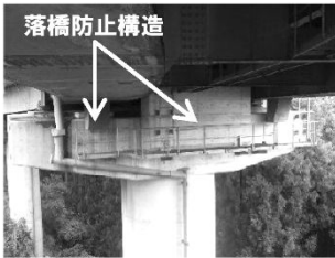
写真-1 端支点の落橋防止構造 写真-2 中間支点の変位制限構造
