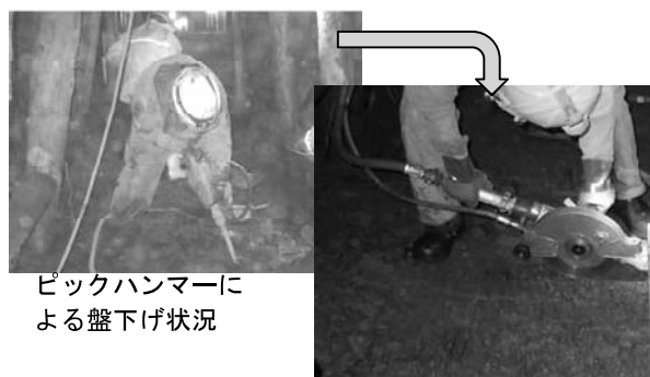
ダイヤモンドカッターによる整形状況
