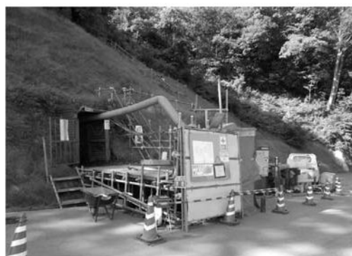
写真-1 T55L-1横坑坑口状況。
