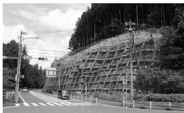
図-9 崩壊箇所工事完成
