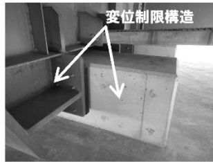
写真-1 端支点の落橋防止構造 写真-2 中間支点の変位制限構造
