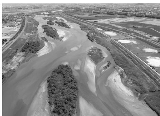
図-1 事業区間（矢作川河口部）。
