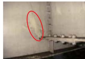
図1 A橋の亀裂損傷状況
