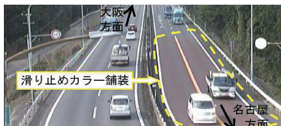
図-4 滑り止めカラー舗装(12.9kp付近)
