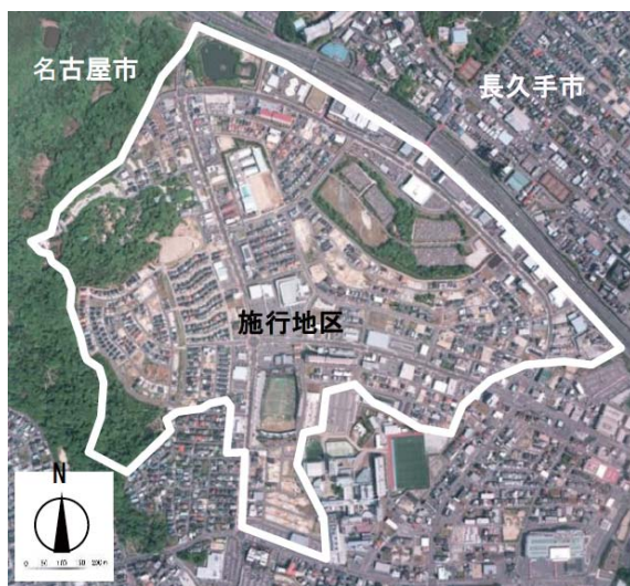
写真-2 施工後の様子(平成26年)
