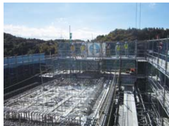
鷺見橋柱頭部
