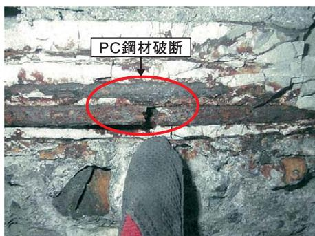
写真-2 PC鋼材破断状況
