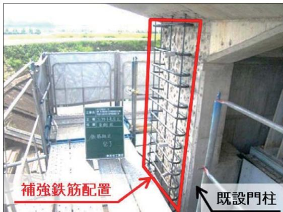
図-1 耐震補強(門柱)の例(城田寺逆水樋門)
