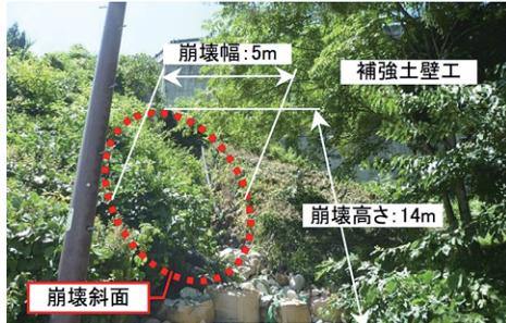
図-3 崩壊箇所の規模と現地状況
