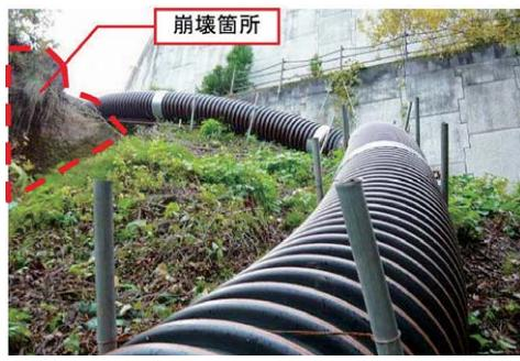
図-6 崩壊箇所を避けた斜面への単管パイプ固定
