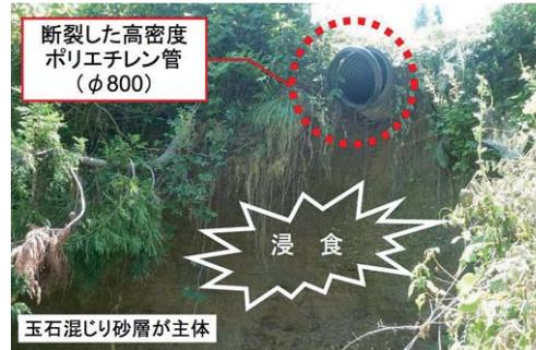
図-4 ポリエチレン管の断裂
