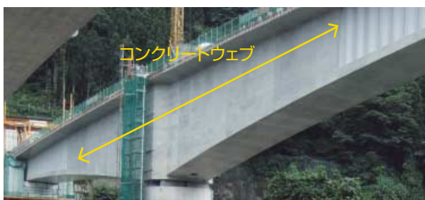
P1 橋脚付近
